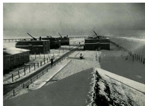
Flakbatterie Wybelsum am Emsdeich
