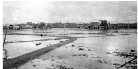
Batterie Uphusen umgeben von Wasser
