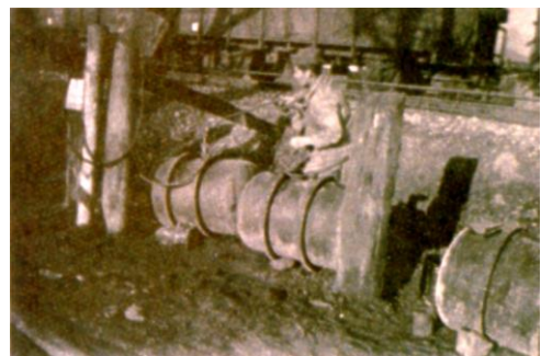
Nebeltonnen am Bahnhof Emden-Süd
