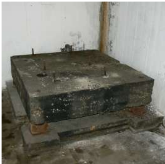
Sockelplatte für den Rundkessel zur Erwärmung der Luft. Die Anlagenteile wurden entfernt
