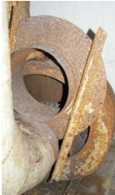
Fliehkraft-Normalbelüfter ohne den Elektromotor
