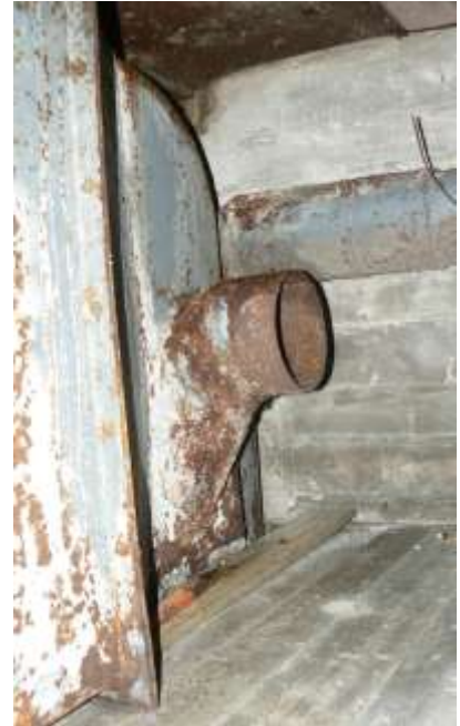
Reste der Entlüftungsanlage im oberen Bereich des Bunkers
