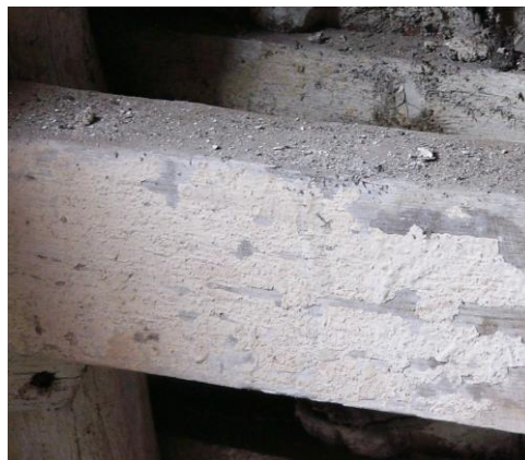
Reste eines Kalkschlämmeanstriches als Ersatzflammschutz in der Dachkonstruktion des Hauses Kranstraße 12, Emden.
