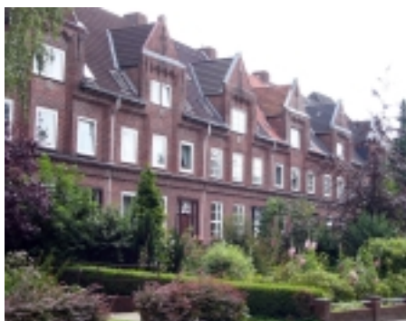
Häuser in der Ringstraße, in der sich die Wache befand Foto: D. Janßen
