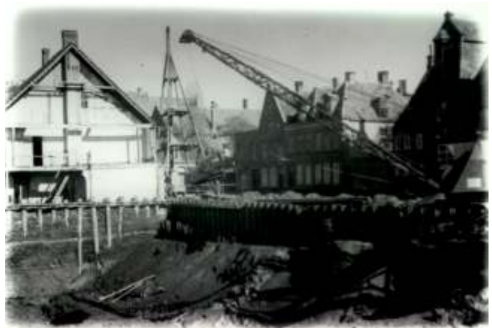
Baustelle des Krankenhausbunkers Am Burggraben
