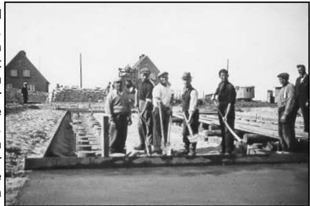
Italienische Vertragsarbeiter beim Betonieren der Sohle des LS-Bunkers Conrebbersweg
