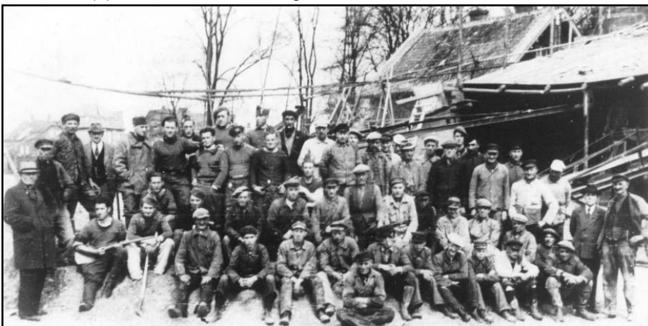
Durch die Firma Benjamins, Emden, wurde der LS-Bunker am Gymnasiumsplatz im Jahre 1942 durch 65 Bauarbeiter errichtet. Unter ihnen waren Italiener, Belgier und Holländer.
