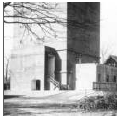
Transformatorstation am Bunker Gymnasium, rechts im Bild
