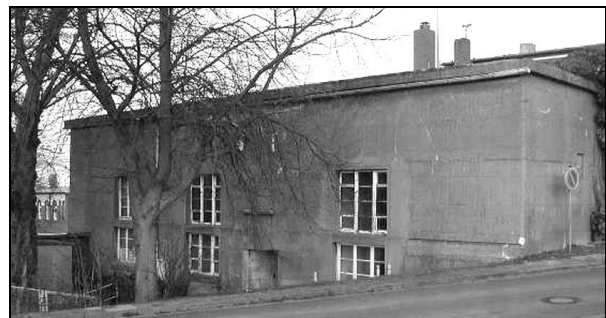
Der entfestigte Bunker an der Nesserlander Schleuse, heute
