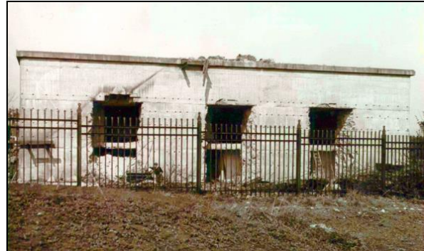
Entfestigter Luftschutzbunker 1949 an der Nesserlander Schleuse, im Vordergrund das Zollgitter
