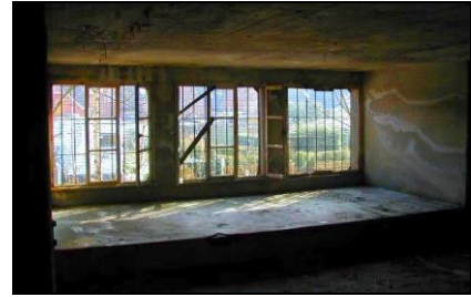
Innenaufnahme mit den eingesprengten Fensteröffnungen, 2002
