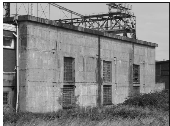
Entfestigter Bunker am Südkai, heute
