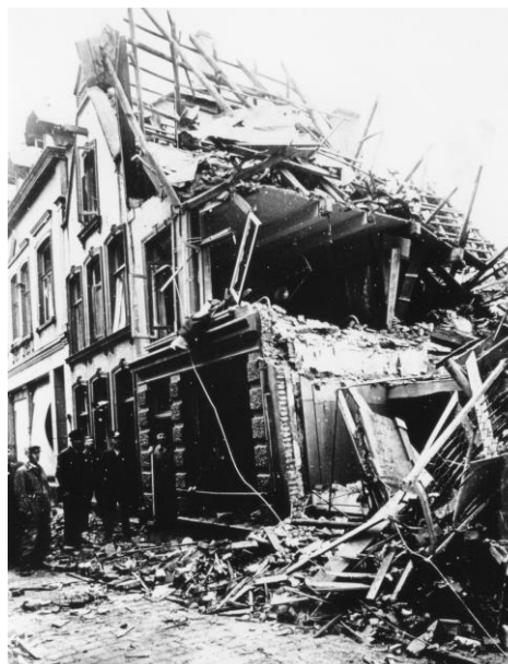
Zerstörte Wohngebäude Am Falderntor
