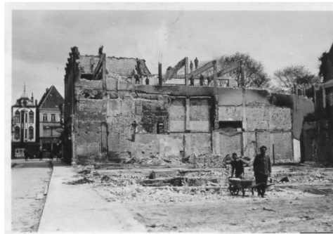
Abbruch der Ruine
