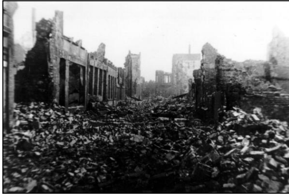
Blick von der Kleinen Brückstraße in die Hofstraße in Richtung der Großen Faldernstraße nach dem 6. September 1944
