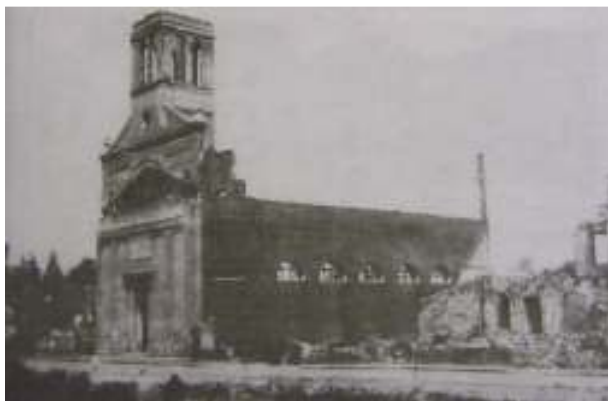
Auch dieses Emders Bauwerk wurde am 6. September 1944 von Bomben zerstört: die katholische Kirche St. Michael in der Straße Hof von Holland. EZ-Archiv
