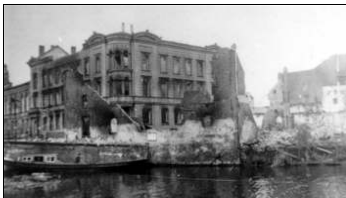
Das ausgebrannte Tegrphengebude (A- und B-Gebude) gesehen von der Strae Hinter der Halle
