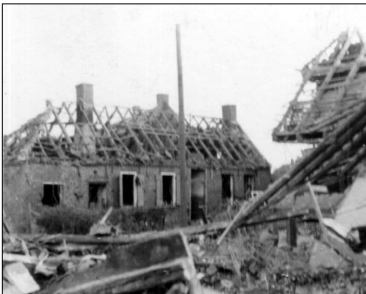
Zerstörungen im Dorfkern von Larrelt
