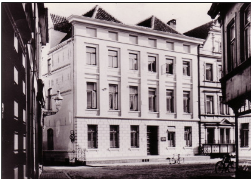
Wohnhaus Alter Markt 1, gesehen von der Straße Zwischen beiden Märkten aus. JaL, Bildarchiv Lfd.Nr. 0131, Nr. 15
