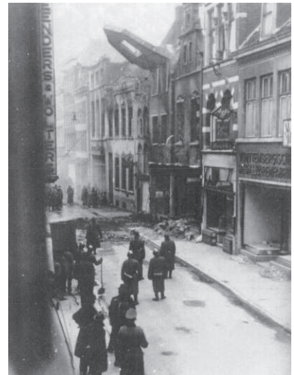
Bild 3: Ein Giebel drohte einzustürzen und wurde vorsorglich eingerissen.
