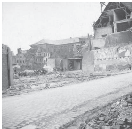
Nach der Trümmerräumung
