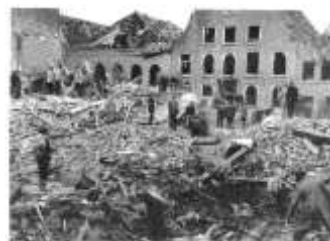
Schadenstelle neben dem Telegrafenamnt Osterstraße
